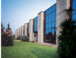
USINE DE PAVIE : IT COOLING
