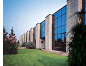
USINE DE PAVIE : IT COOLING
