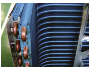
REVÊTEMENT BLUE FIN SUR ÉCHANGEUR CUIVRE - ALUMINIUM
